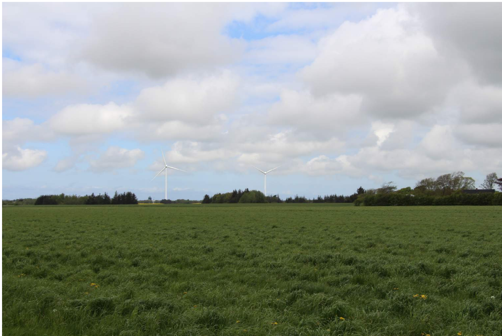
2 stk. Vestas V117 150 meter totalhøjde set fra Rakkebyvej i vestlig udkant af Rakkeby
